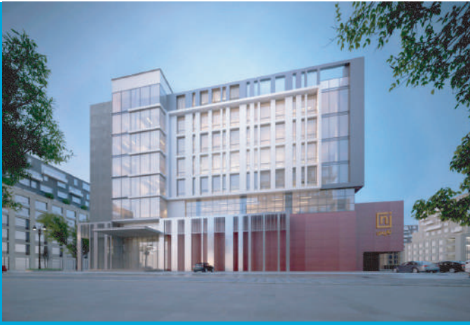
برج ريتال Retal Tower
